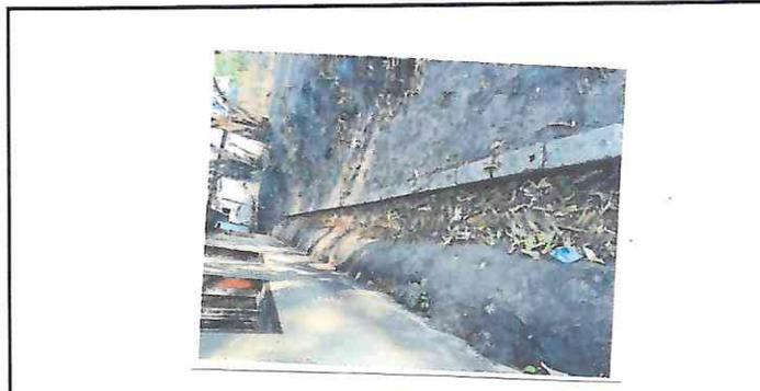
Foto 5: Cuneta de concreto quebrada
